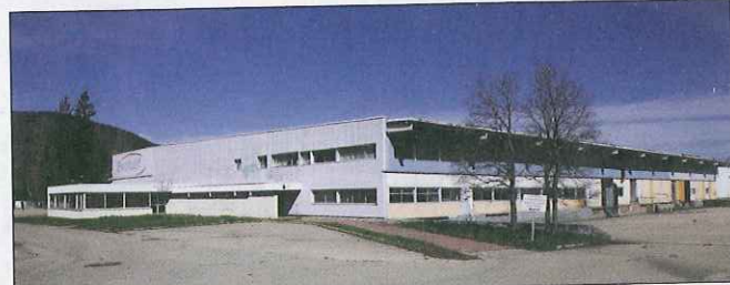
À Saint-Honoré, le site Évolutif fait l'objet de travaux de dépollution.
