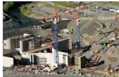
Illustration: Chantier EDF de Romanche Gavet Copyright: EDF- Christophe Huret
